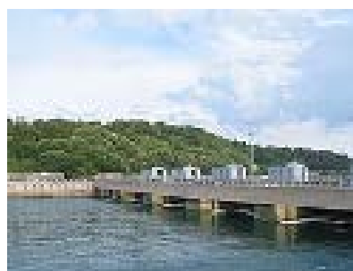
Usine marémotrice de la Rance
